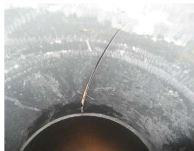
軸方向クラック 管内状況
