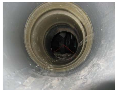
止水・補修施工 後状況
