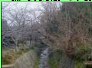
川下から見た整備前の傍示川 右側が整備予定場所
