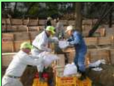
土砂の入った土嚢をベルトコンベアに乗せるのは大変でした
