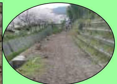
川下から見た整備後の傍示川 右側が整備された遊歩道
