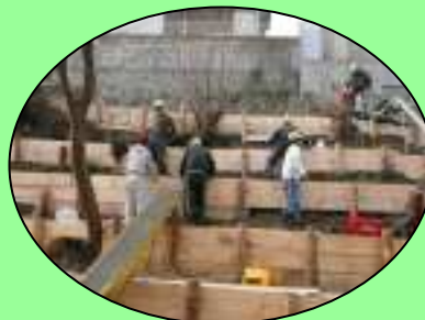
土嚢は土留めの内側へ均等に 入れ込んでいきます
