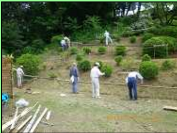
半割した竹で水路を設置しています
