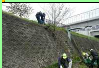
不法投棄品を引き上げています
